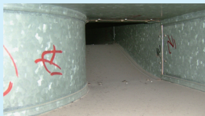
ダクト内部清掃
